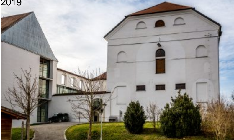
Herrenchiemsee, Inseldom, Zustand vor der Sanierung, 2019
